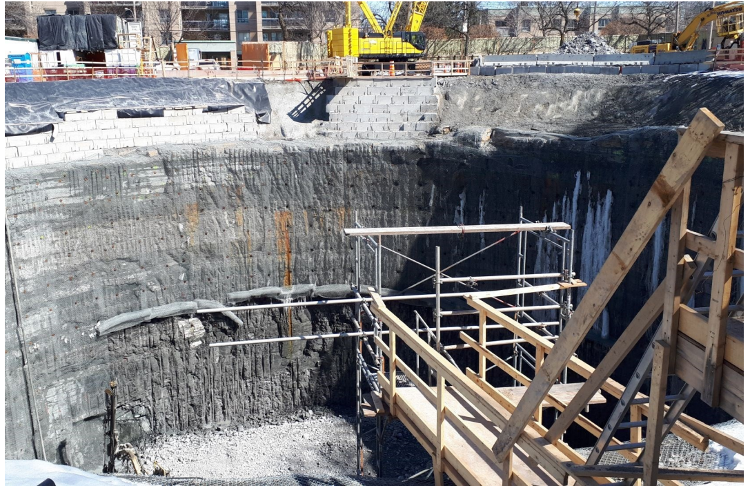
Bassin de rétention Lavigne, situé dans l'arrondissement d'Achutes-Cartierville près de Montréal.
